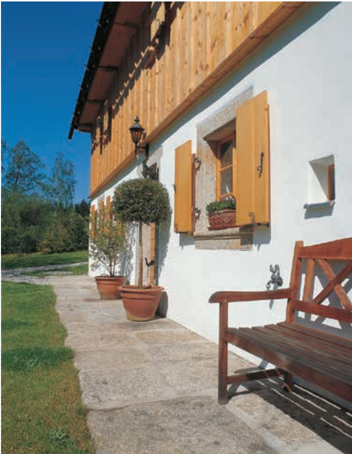
Sockelgestaltung an einem Wohnstallhaus in Sickersreuth
