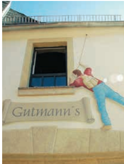
Fassade „Gutmann's“ in Kirchenlamitz mit Illusionsmalerei aus Rajasil SHF (Siliconharzfarbe)
