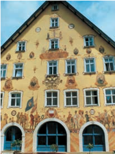
Lüftmalerei mit Rajasil SHF (Siliconharzfarbe) am Rathaus in Horb
