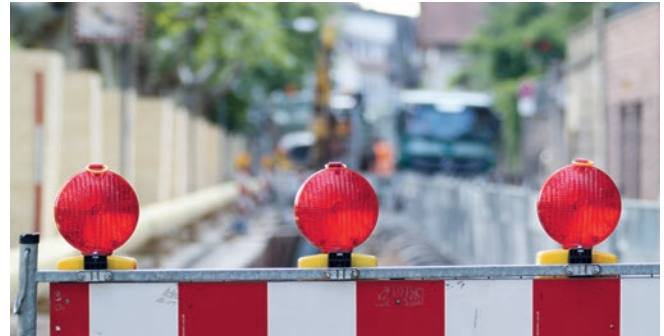
Die Technische Regel ASR 5.2 schützt Beschäftigte bei Arbeiten im fließenden Verkehr.
