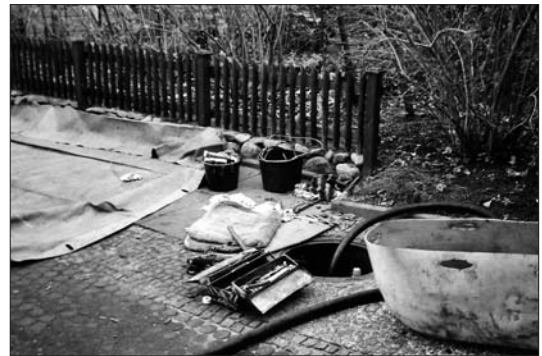
Foto 2: Ölerfassung mit faltbarem Kunststofftank
