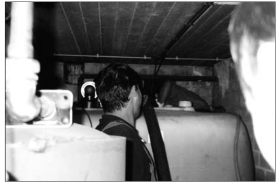
Foto 1: Batterietank ohne Einstiegsmöglichkeit
