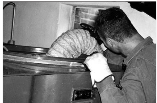
Foto 3: Kellertank mit Einstieg
