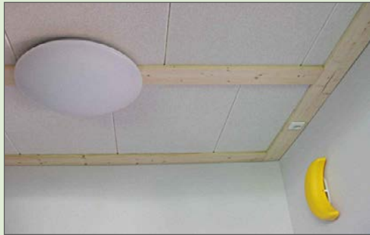
Akustikplatten an der Decke
