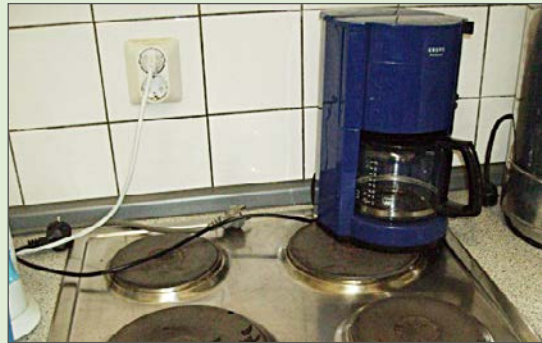
Steckdose ungünstig angebracht
