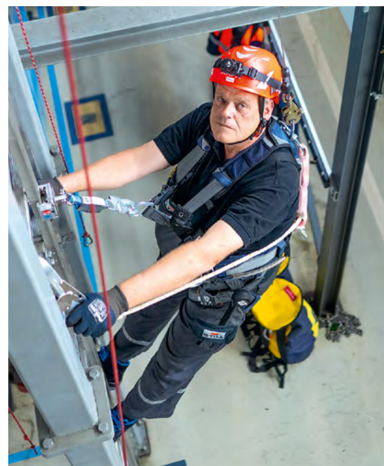
Holger Peters hakt seinen Auffanggurt in das Höhensicherungsgerät und den Bandfalldämpfer an der Leiter ein.
